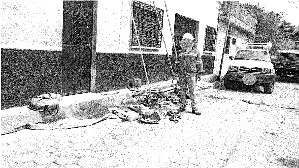
Herramientas y equipos asignados a la cuadrilla no coinciden con lo reportado por la Distribuidora
