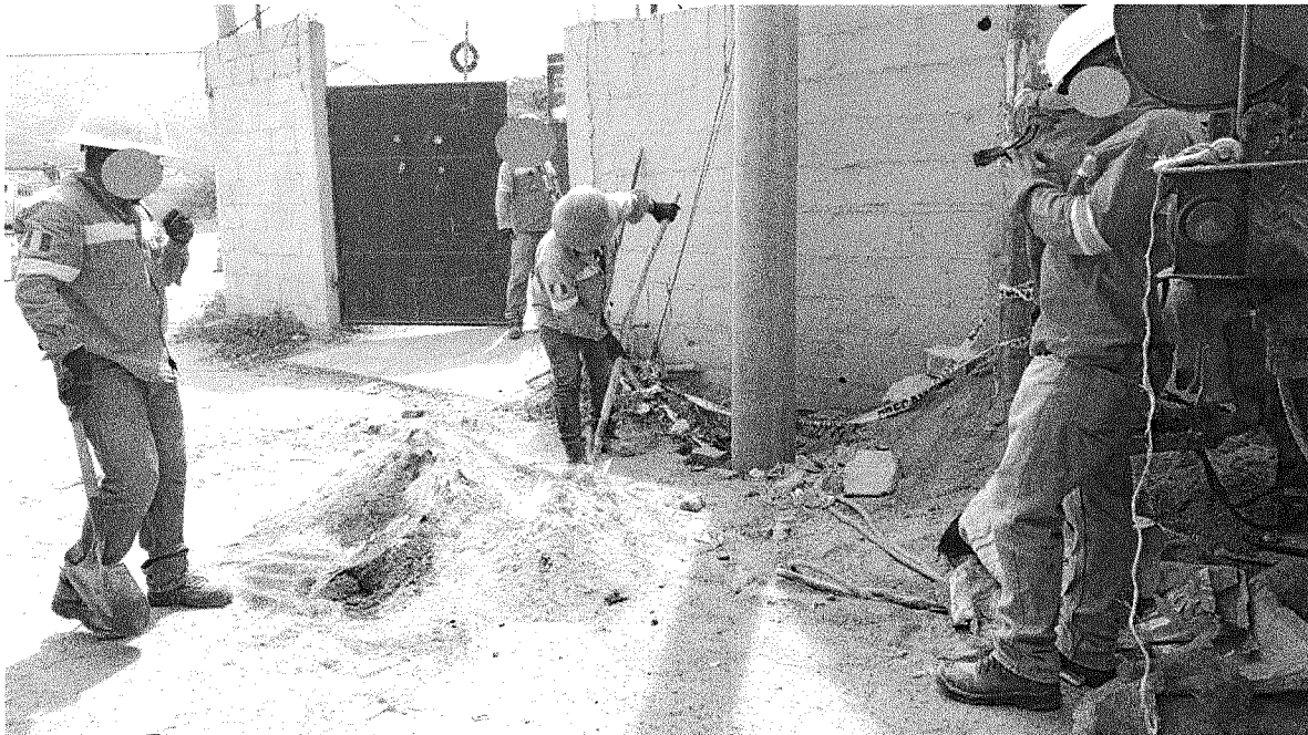
Personal sin la totalidad del equipo de protección mínimo
